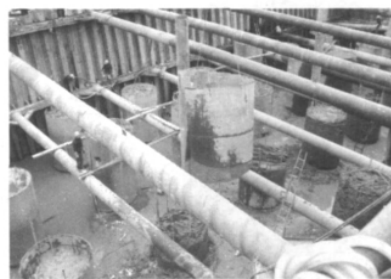
图4 钢板桩围堰桩基施工示意图
