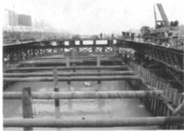
图6 钢板桩围堰示意图
